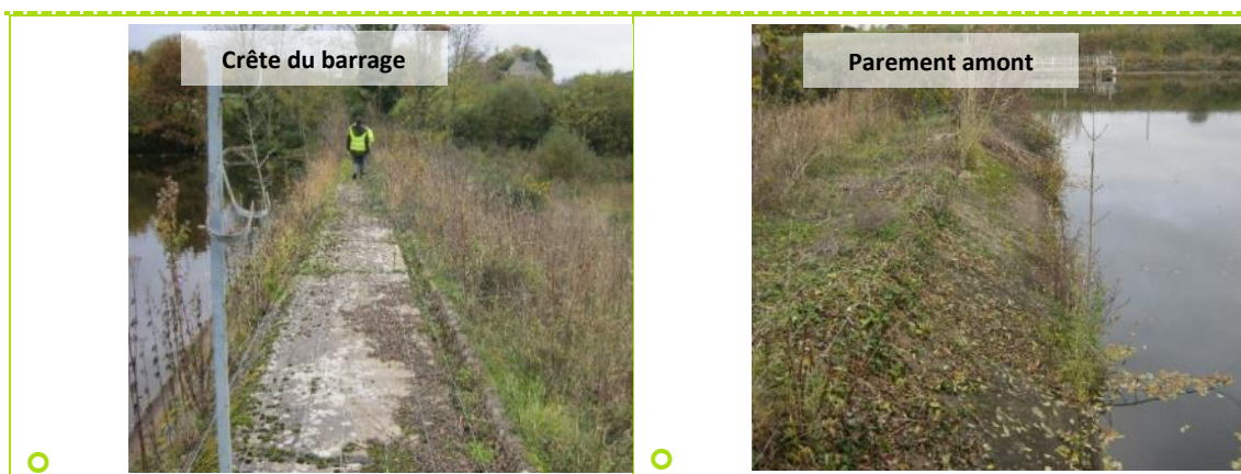
Figure 2 : Barrage de Pont-Avet - Photographie de la crête et du parement amont
