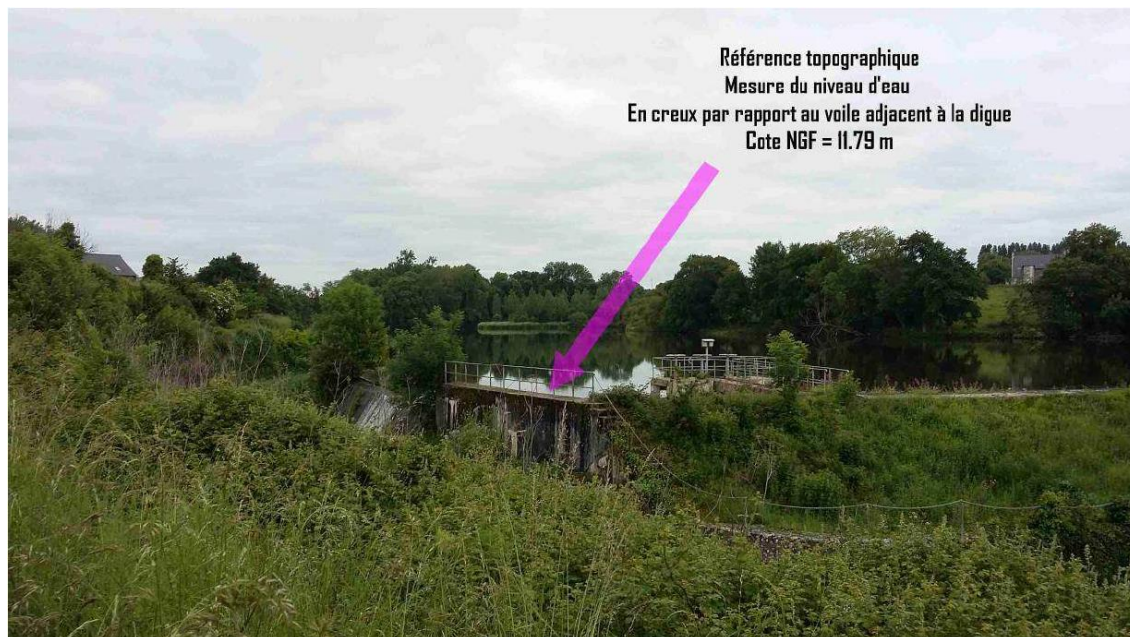
Figure 5 - Localisation de la référence topographique des mesures de niveau
